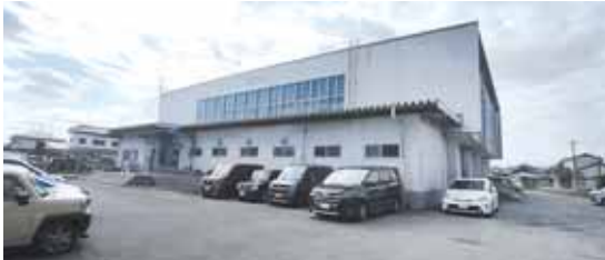
周辺に配慮した解体も重要
